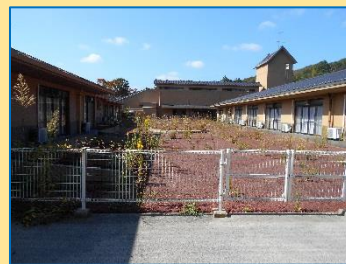
平成 27 年 12 月に除染工事完了しております。(H28.10.19 撮影)
